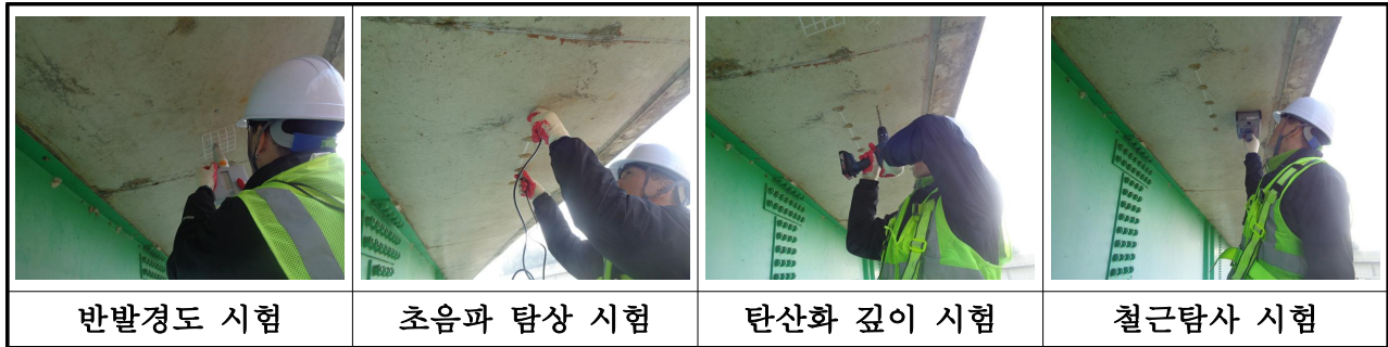
【사진 3.25】 콘크리트 내구성조사 전경
