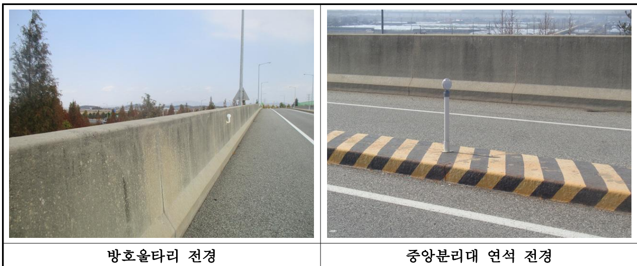
【사진 3.23】 난간 및 연석 전경
