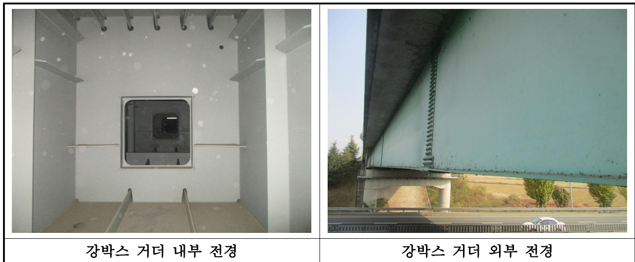
【사진 3.5】 강박스 거더 전경
