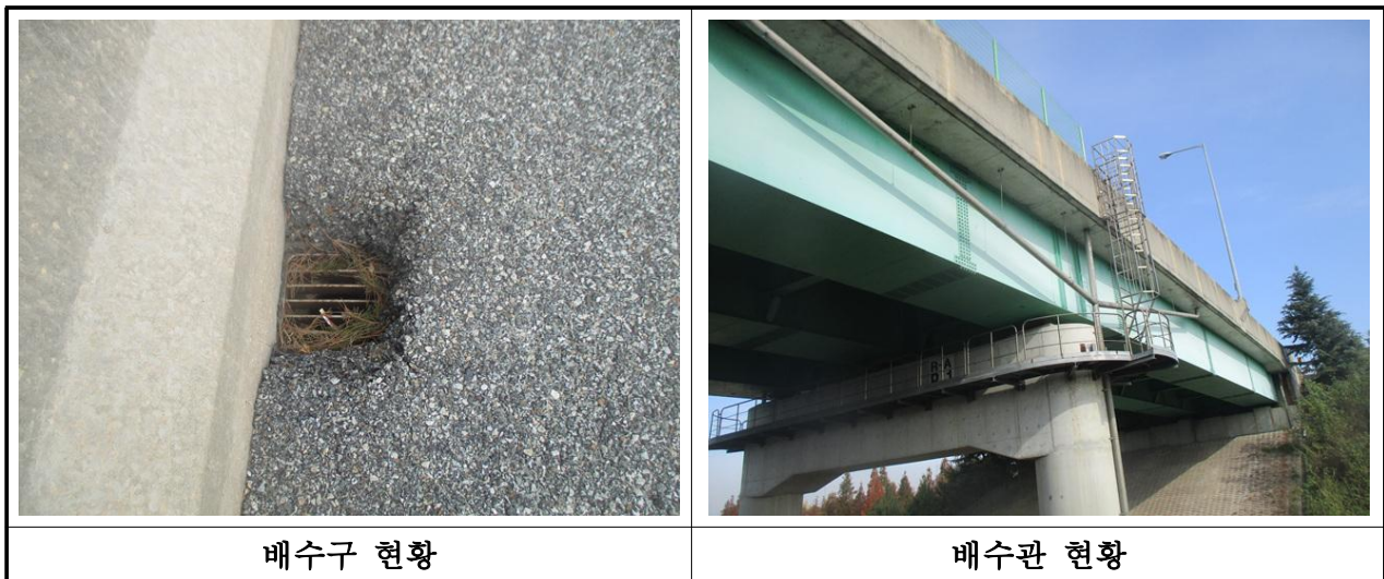
【사진 3.21】 배수구 및 배수관 전경
