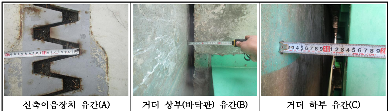
【사진 3.19】 신축이음 유간 측정방법
