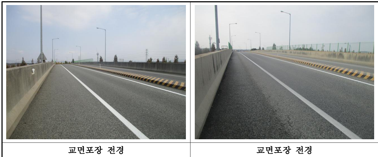
【사진 3.20】 교면포장 전경
